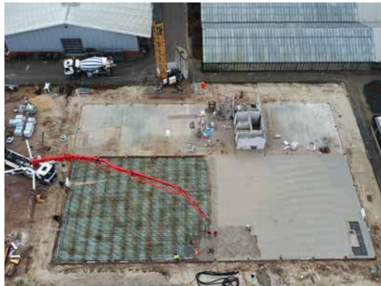
Das Gießen des Hallenfundaments von oben betrachtet.
