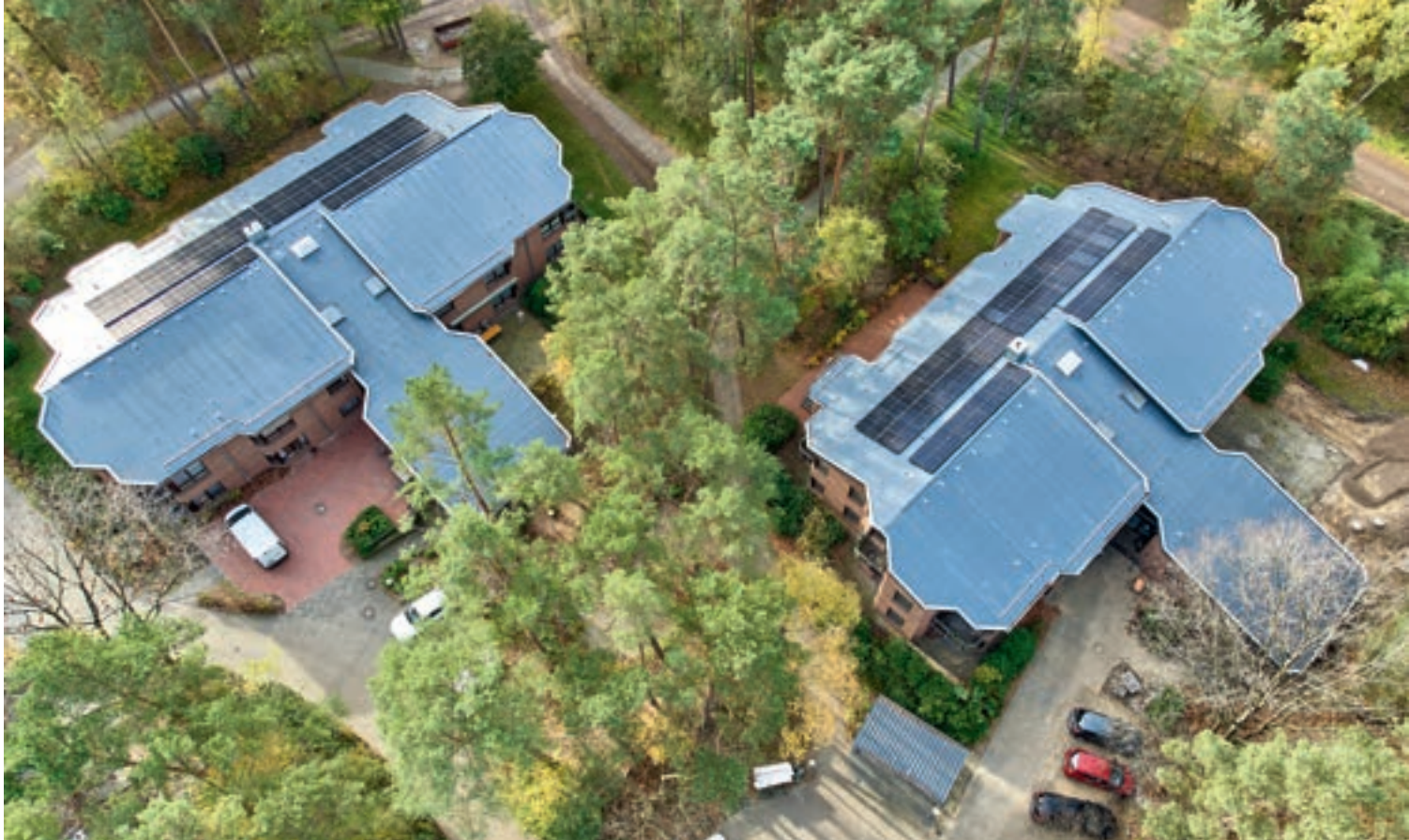
Im Zuge der Sanierung der Dächer der Wohnanlage Darne wurden zwei Häuser mit einer PV-Anlage ausgestattet. Seit März 2023 versorgen sie die Anlage mit eigenem, grünem Strom.
